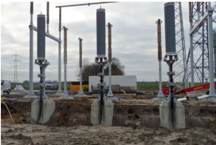
Abb. 3-4: Beispielhafte Darstellung dreier Kabelendverschlüsse
