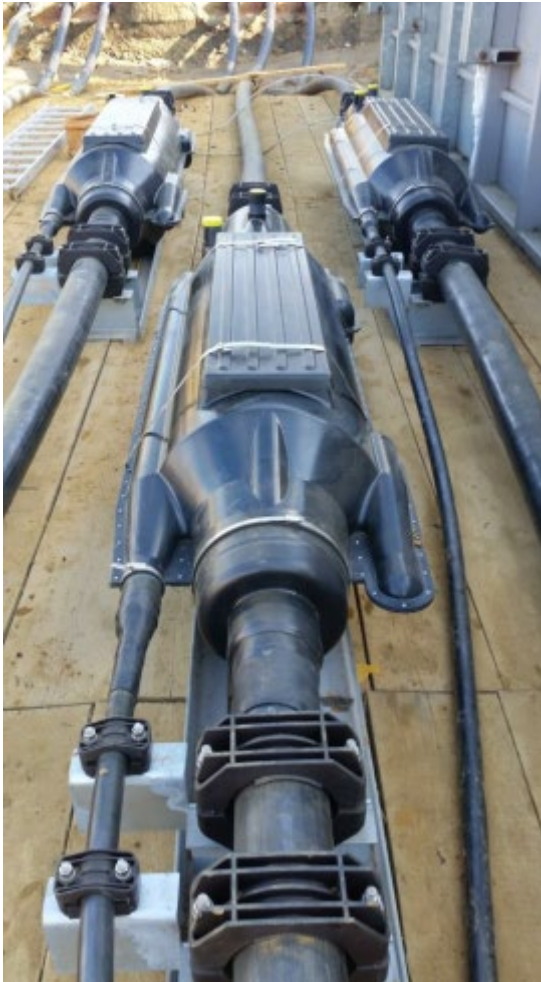
Abb. 3-3: Beispiel für eine Muffenverbindung
